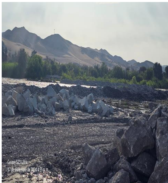
FOTOGRAFIA 02: Vista en la que se aprecia la carencia de diques secos con acumulacion de material propio en ambas margenes del río.
